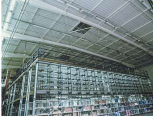
▲ STOCKAGE (67) : ISODIM BD, DOUBLE LARGEUR, EN ALTERNANCE DANS LES RAMPES D'ÉCLAIRAGE.
