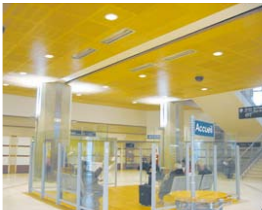
▲ ZONE D'ATTENTE DE GARE (75) : ISODIM HD CORPS INOX ENCASTRÉ AVEC LE KIT INOX.
